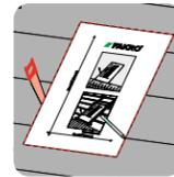
Un gabarit est fourni, spécifique au modèle de puits de lumière, pour un marquage simple et rapide de l'ouverture brute.
